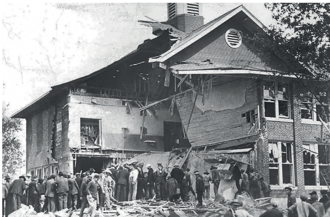
Рис. 2. Здание школы «Бат» после взрыва, 1927 г.
